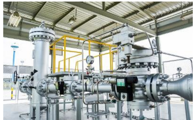
ระบบ Metering สถานีปรับปรุงคุณภาพก๊าซ
